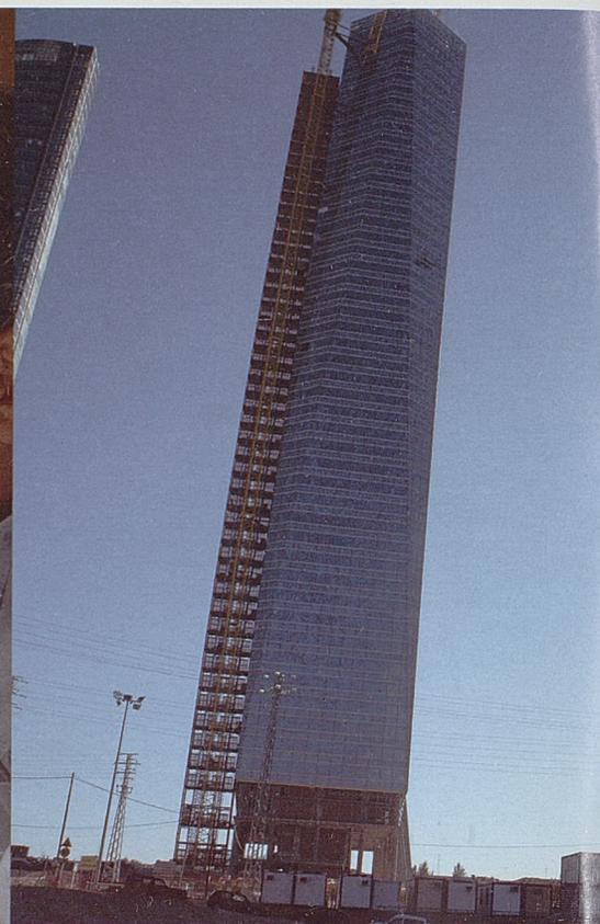
La forma de la torre es aerodinámica para resolver uno de los retos más importantes en este tipo de edificación, los esfuerzos horizontales. La fachada de la torre responde a una doble necesidad de solucionar tanto los aspectos técnicos como la imagen, esto se consigue con un doble cerramiento.
